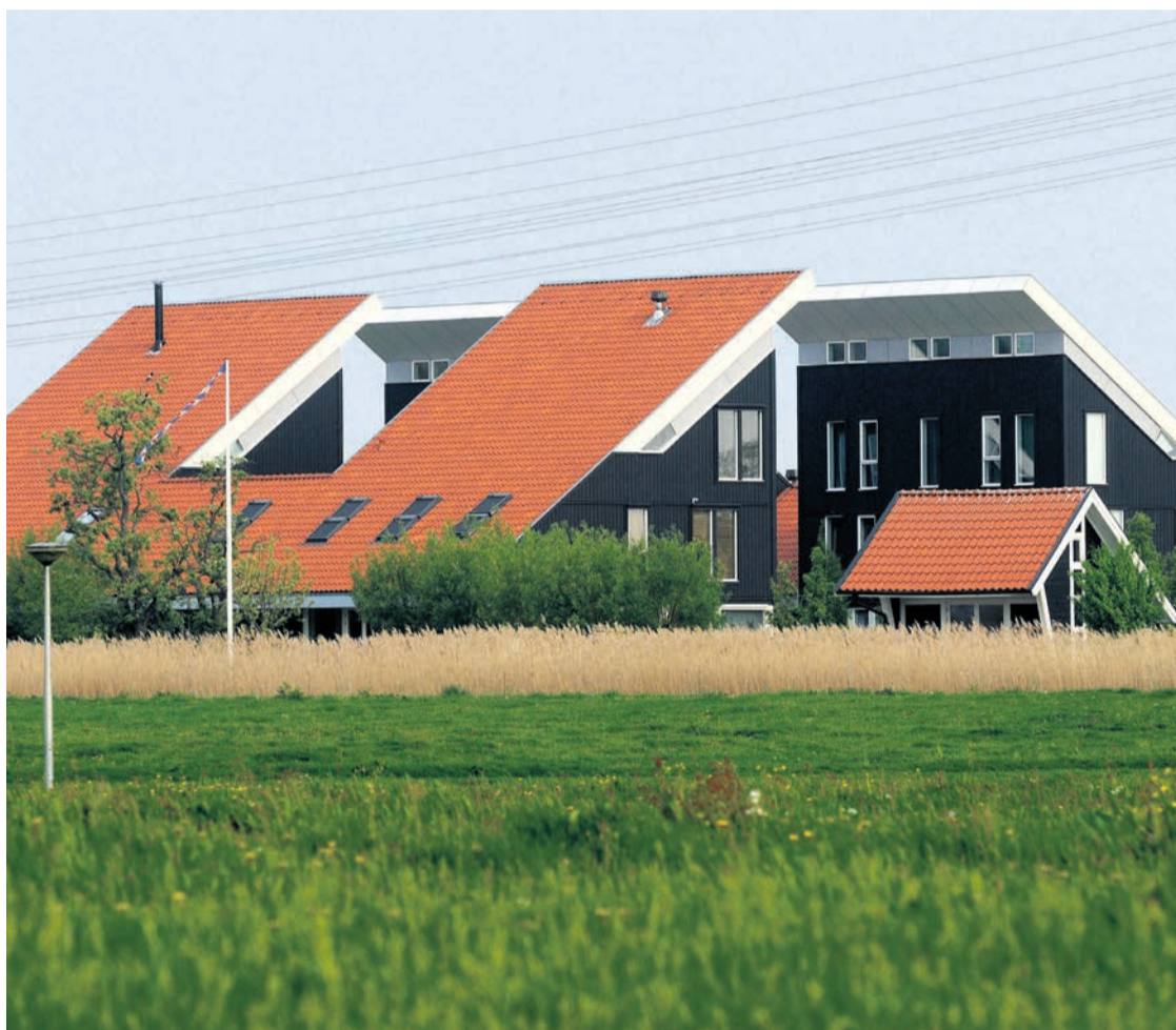
Rein de Valk: „Ik heb zo'n beetje dezelfde dakhelling als die van de boerderij gebruikt, zodat de daken precies binnen de oude contouren passen.” Foto's: Frans Andringa
